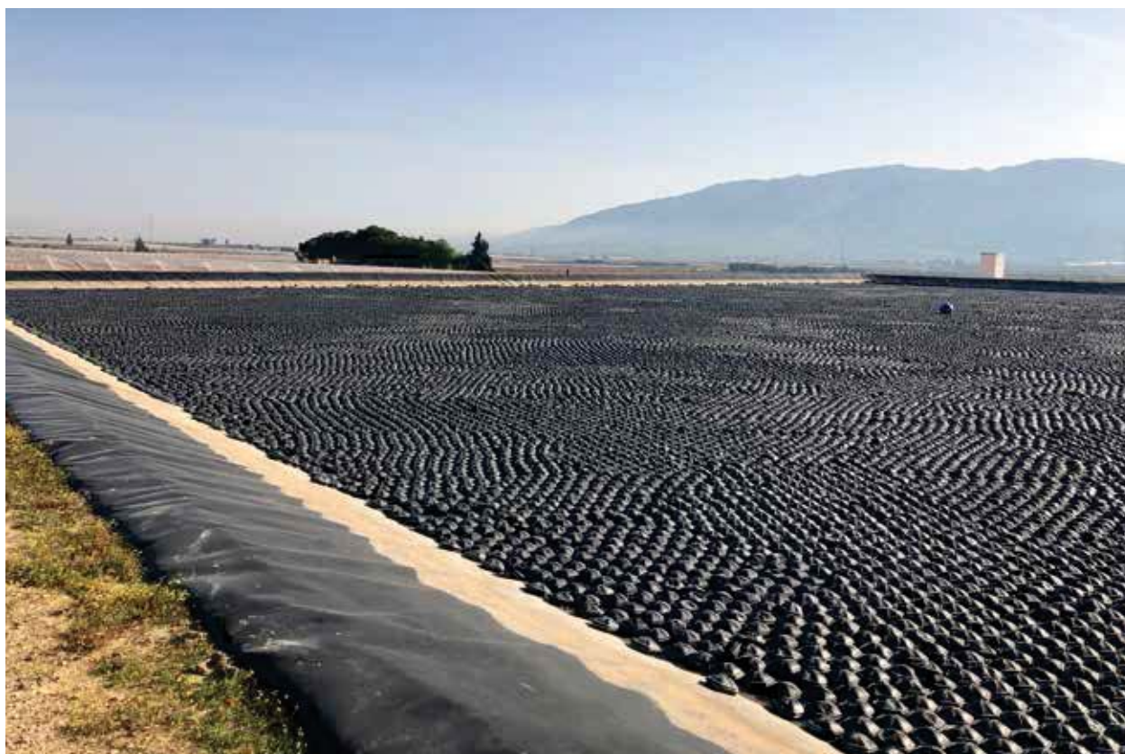
Figura 2. Cobertura flotante modular para mitigar las pérdidas por evaporación en balsas.
